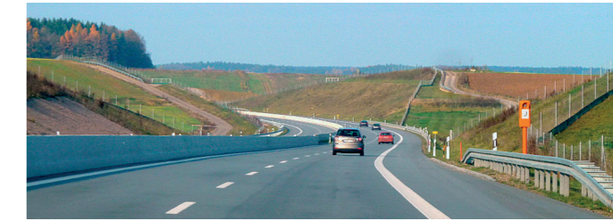
Wir setzen den Weiterbau der B15 neu durch – hier die Neubaustrecke auf Höhe Ergoldsbach.
